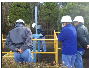
水門 開閉手順確認
