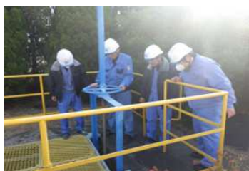
水門 開閉手順確認
