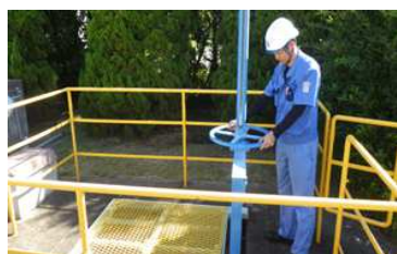
水門 開閉手順確認
