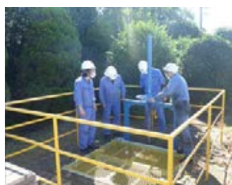
水門 開閉手順確認
